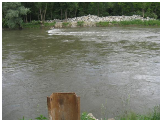
V Pofilu drče – začetek gradnje
